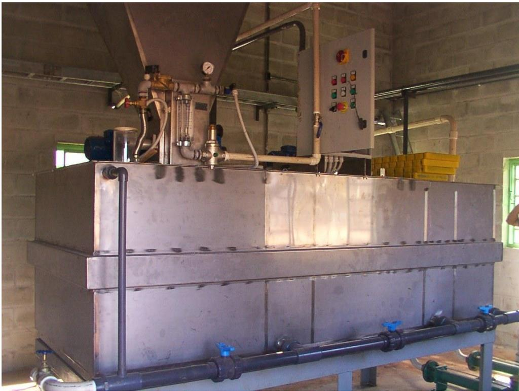
A planta de floculante da Oretec é um sistema automático para preparação contínua de solução de floculante de fácil operação, alta confiabilidade e baixa manutenção.
